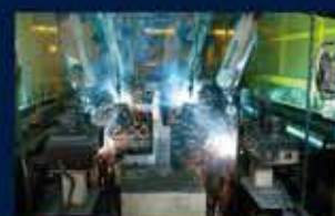
自動溶接装置
