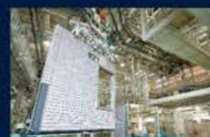
大型機械による外壁取付
